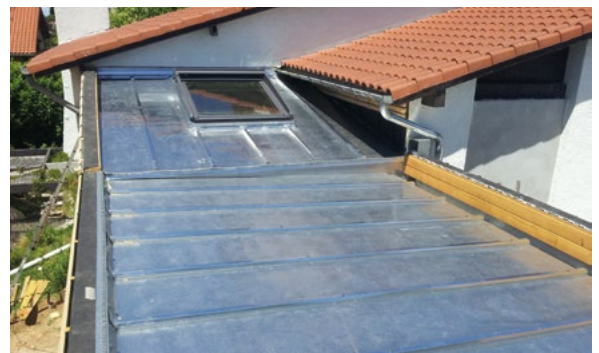
Toiture de l'extension en zinc.
