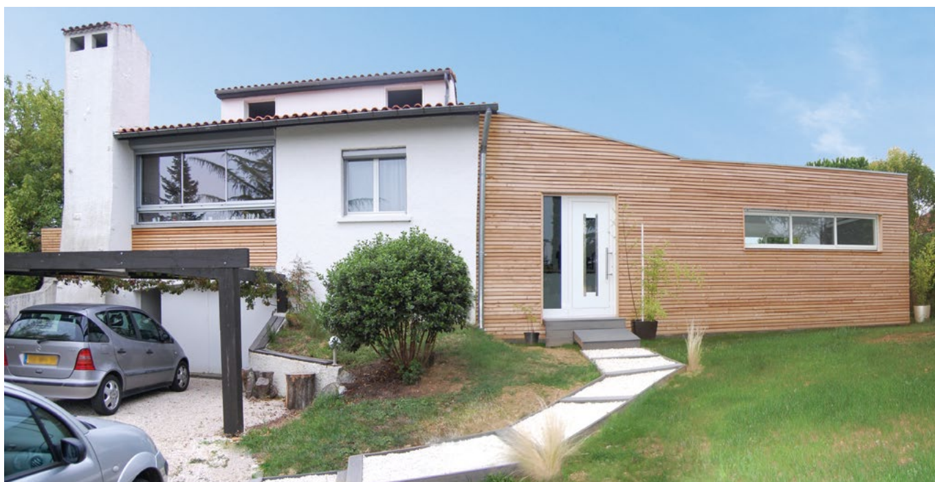
Maison agrandie d'une extension bois. Le bardage en mélèze à claire-voie s'intègre parfaitement à cette maison des années 1970. Un rappel de bardage a été fait sous la fenêtre de la cuisine (à gauche).
