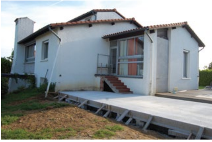
Chantier. Ci-dessus, la dalle a été réalisée. L'ossature bois est montée sur la dalle. À droite, l'isolant en fibre de bois Homatherm est posé entre les montants de l'ossature.
