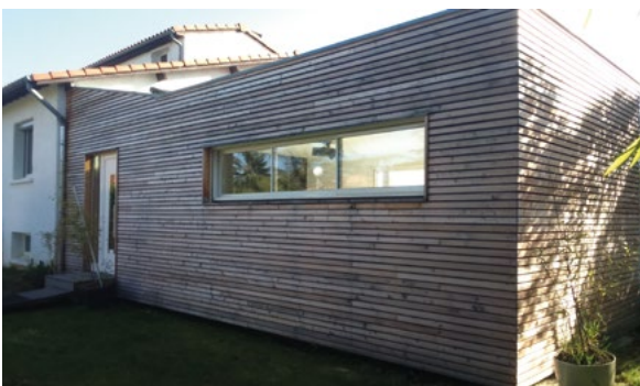
Angle sud-ouest de l'extension. Pose du bardage particulièrement soignée.
