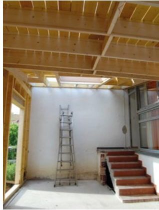
Chantier. Ci-dessus, la dalle a été réalisée. L'ossature bois est montée sur la dalle. À droite, l'isolant en fibre de bois Homatherm est posé entre les montants de l'ossature.
